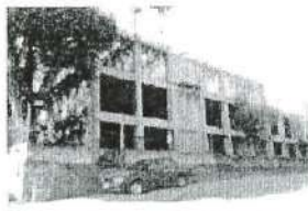
Construccion Col. Zapata
